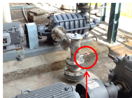
写真2 真空ポンプへの接続配管
