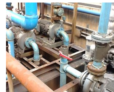
末端フート弁を使用しているライン
