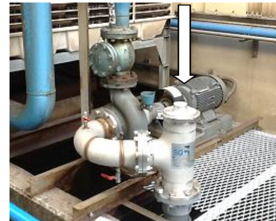
末端フート弁を使用しているライン
