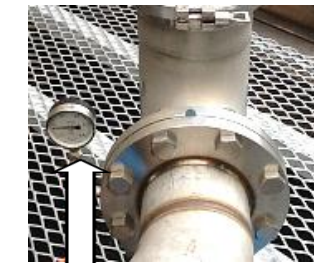
真空計を設置して、目視管理している。
