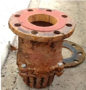
錆びてしまったフート弁
