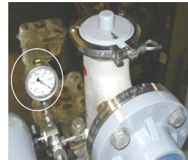
フートバルブ 以下に水がない
