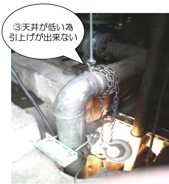
③ポンプ室の天井が低いので、一回で引き上げられない。そのため、引き上げ作業の途中で配管のフランジを外し分割して引き上げる。
