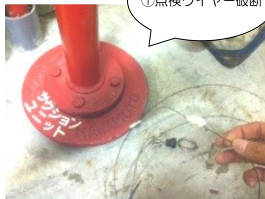
①フート弁釣り用フックを使用した際、ワイヤーが切れてしまうことがある。是正せずにいるとワイヤーが絡んでしまうため、ワイヤーの付け替えで、配管を引き上げて作業が必要になる。
