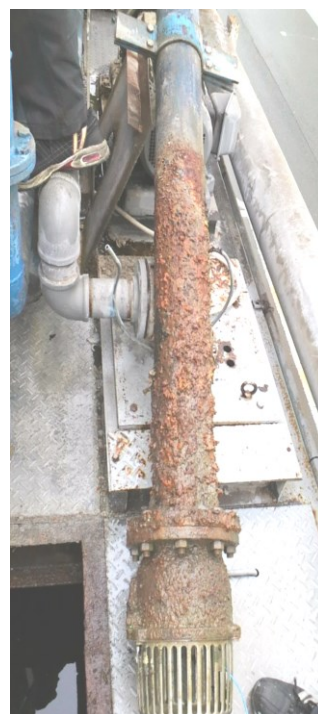
引き揚げた配管
