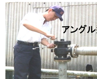
図1 ボルトの取り外し
