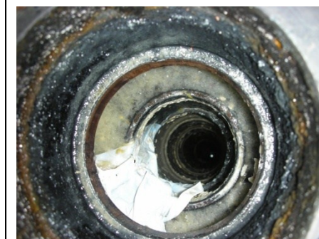
図4 弁箱内の清掃
