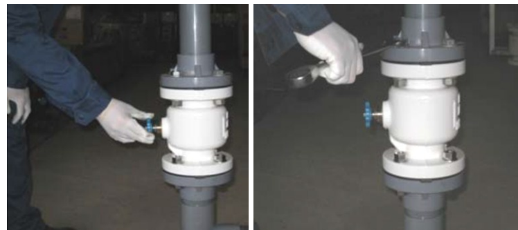
図1 バイパス弁開放 図2 配管からバルブ取り外し
