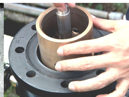
図3 弁体一式の引き上げ
