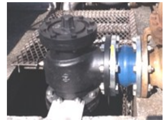
SML-DT 施工状況
