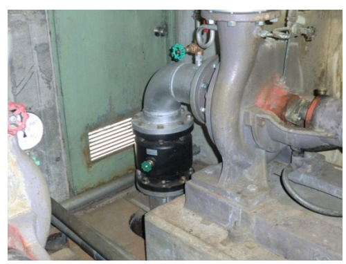
現場配管写真
