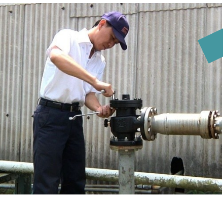
① バルブの蓋のボルトナットを外す
