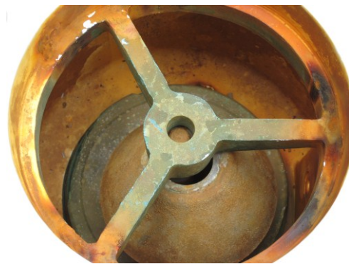
腐食により外れた緩衝傘
