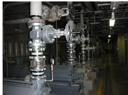
新宿センタービル
