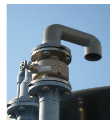
負圧を解消する吸気弁
