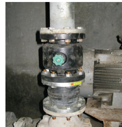
配管設置写真
