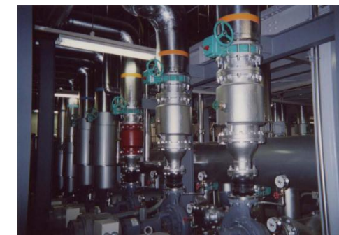
配管設置状態
