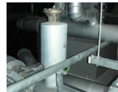
設置した給排気弁
